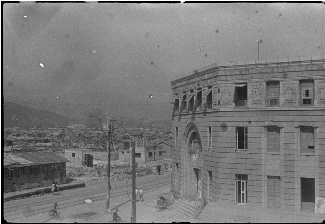
ABBILDUNG 8: GEBÄUDE DER BANK JAPAN 1946 IN HIROSHIMA IN DER RIJO DORI STREET 380 METER SEITLICH UND UNGEFÄHR 600 METER LUFTLINIE ENTFERNT VON DER ANGENBLICHEN „ATOMBOMBENEXPLOSION“ UND DEM ZENTRUM DER DRUCKWELLE 1945.
